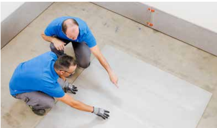
Choose the layout of the tiles | Selecciona la disposición de las piezas | Sélectionner la disposition des pièces | Wählen Sie die Anordnung der Fliesen
