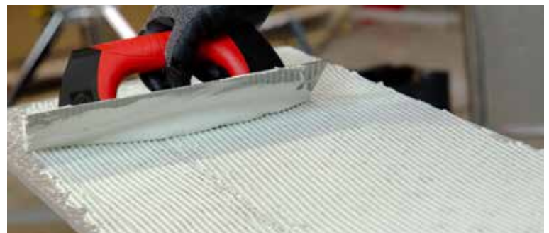
Make sure the thickness of the layer of adhesive cement is uniform | Asegúrate de que el grosor de la capa de cola sea uniforme | Veiller à ce que l'épaisseur de la couche de colle soit uniforme | Vergewissern Sie sich, dass die Kleberschicht gleichmäßig ist
