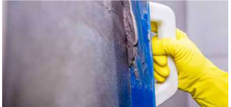
Use a grout trowel to affix the material | Utiliza una llana de rejuntado para fijar el material | Utiliser une spatule pour joints pour fixer le matériau | Verwenden Sie eine Fugenkelle zum Andrücken des Materials
