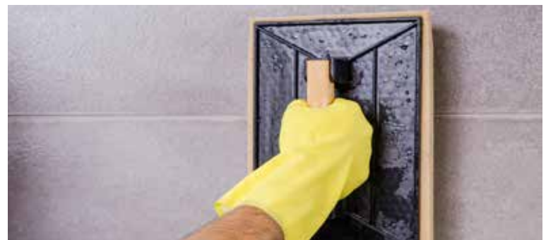
Remove any leftover grout and other dirt | Elimina los residuos de junta y demás suciedad | Éliminer les résidus de jointoiment et autres saletés | Entfernen Sie Fugenmaterialreste und andere Verunreinigungen
