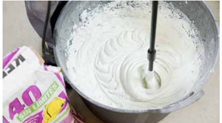
Adhesive cement | Cemento de agarre | Ciment à prise rapide | Klebemörtel
