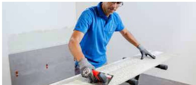
Spread the adhesive cement with a toothed trowel on the tile | Extiende el cemento de agarre con una llanta dentada sobre la pieza | Étendre le ciment à prise rapide à l'aide d'une spatule dentée sur la pièce | Verstreichen Sie den Klebemörtel mit einem Zahnsachtel auf der Fliese
