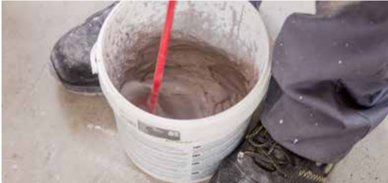
Prepare the grout | Prepara el material de rejuntado | Préparer le matériau de jointoiment | Rühren Sie das Fugenmaterial an
