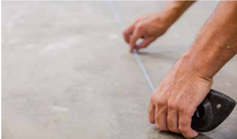
Set the guideline | Plantea la línea maestra | Établir la ligne magistrale | Spannen Sie die Richtschnur
