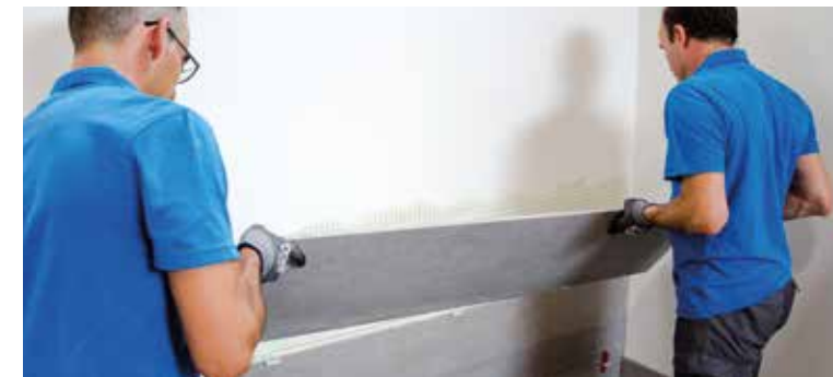
Affix the tile to the pre-prepared surface | Coloca la pieza sobre la superficie preparada | Placer la pièce sur la surface préparée | Verlegen Sie die Fliese auf der vorbereiteten Oberfläche
