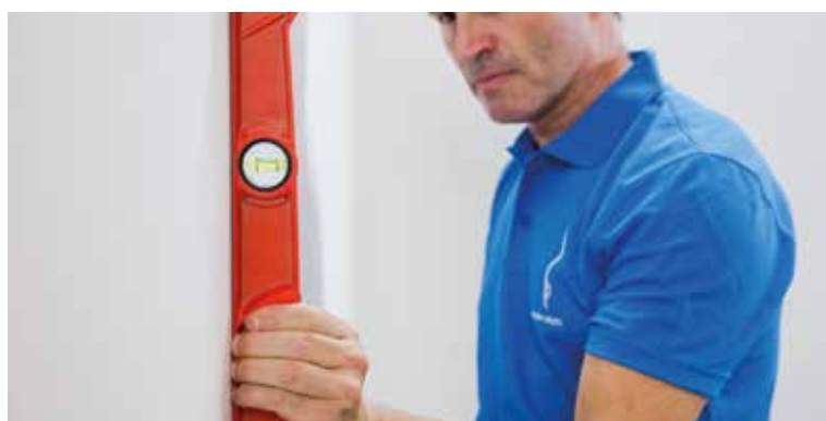
Check the level | Comprueba la nivelación | Vérifier le nivellement | Überprüfen Sie die Nivellierung
